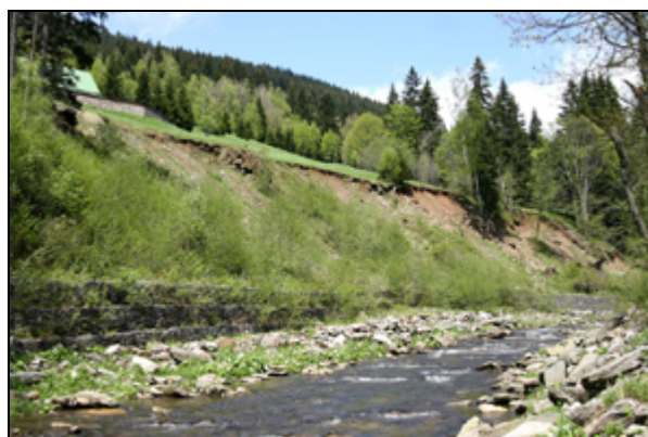
Obr. 4. Dolní Malá Úpa, řeka Malá Úpa, 25.V.2010 Gabion pod sutým břehem jižně od Spáleného Mlýna
