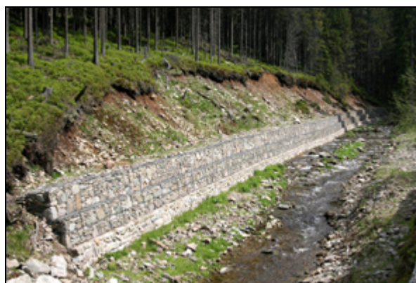
Obr. 5. Horní Malá Úpa, řeka Malá Úpa, 25.V.2010 Gabion pod sutým břehem na úpatí vrchu Haida
