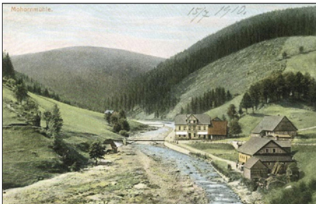
Obr. 6. Dolní Malá Úpa, Spálený Mlýn, 15.VII.1910. Malá Úpa po první regulaci koryta
