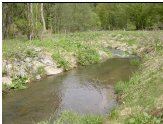
Obr.9. Kanalizované koryto Bušínovského potoka
